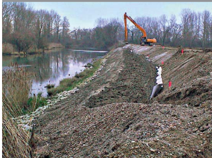
Hochwasserschutzdeich im Bau
