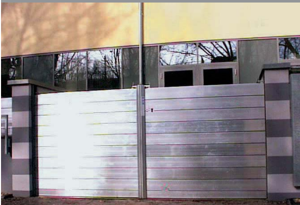
Umlaufender Hochwasserschutz mit teilmobilen Schutzelementen
