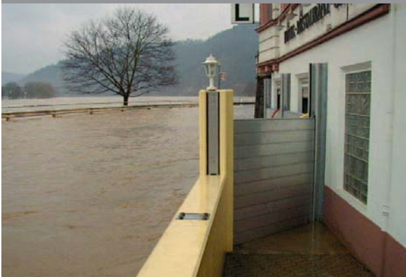
Umlaufender Hochwasserschutz mit teilmobilen Schutzelementen
