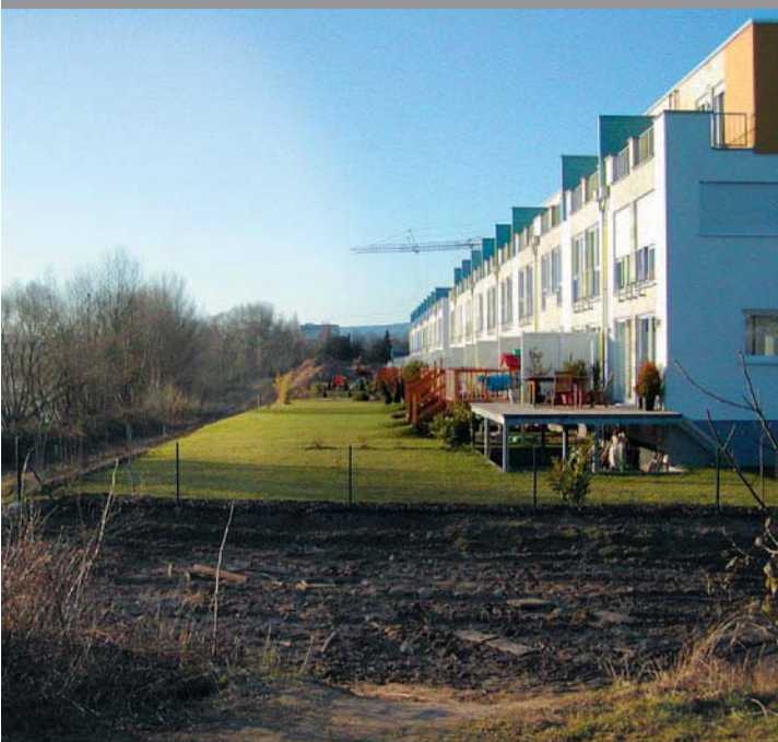
Hochwasser angepasste Bauweise mit Geländemodellierung und erhöhtem Erdgeschossniveau
