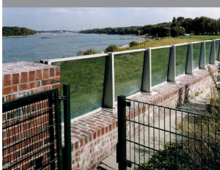
Hochwasserschutzwand mit Sicherheitsglas
