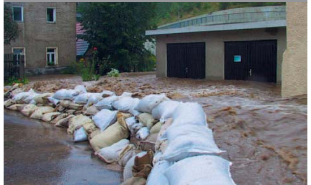
Ein Sandsackwall kann bereits sehr wirkungsvoll sein.
