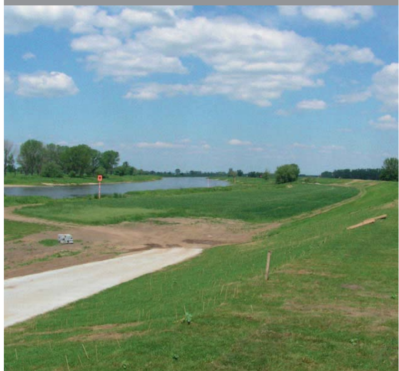
Wiederhergestellter Hochwasserschutzdeich an der Elbe
